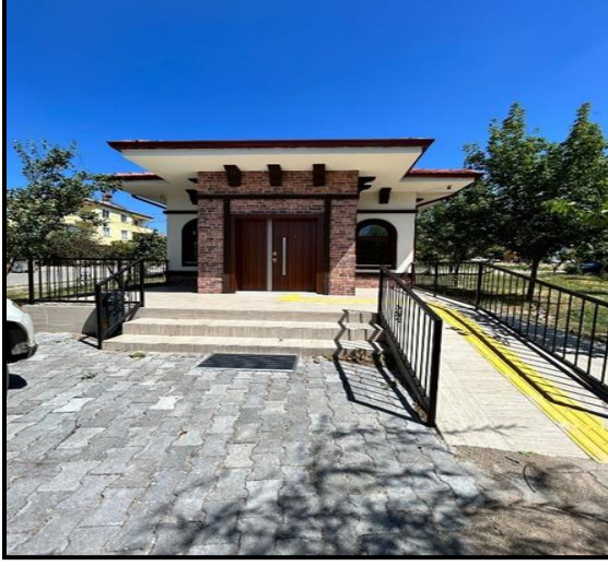
4 Eylül Mahallesi Muhtarlık Hizmet Binası
