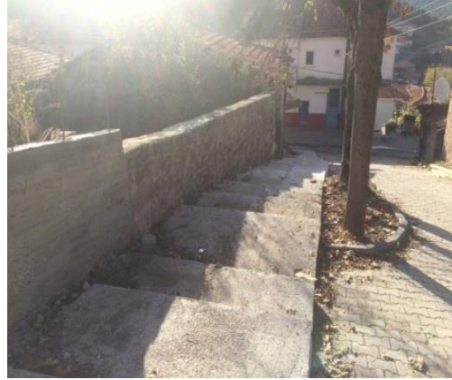
Davutlar Mahallesi Çok Amaçlı Salonuna Çıkış Merdiveni
