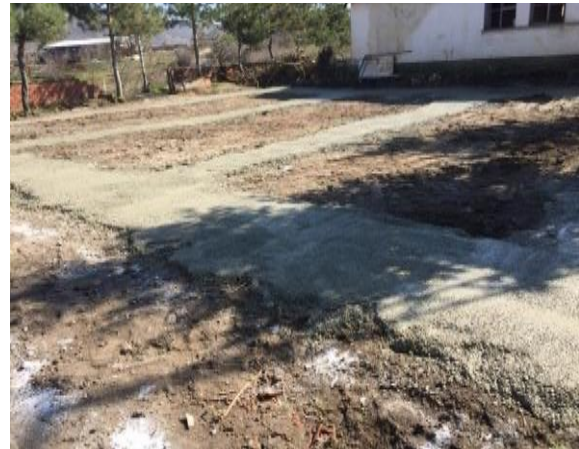
Kireçleme ve grobeton çalışması
