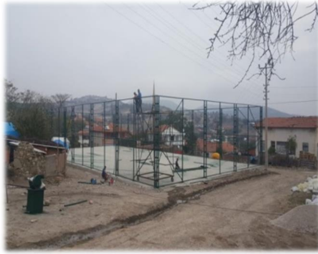
Dedeçinar (kırsal) Mahallesi 20m x 40m ölçülerinde halı saha çelik konstrüksiyon çalışması.
