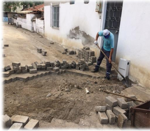
İlçemiz merkez mahallelerinde yapılmış muhtelif parke çalışmalarından fotoğraflar
