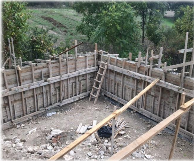
Hamidiye (kırsal) Mahallesi; 15m x 30m ölçülerinde çok amaçlı salonumuzun arka tarafında yapılan perde duvar çalışmalarından fotoğraflar.
