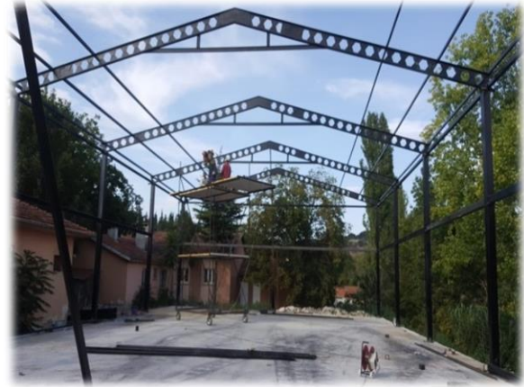
Hamidiye (kırsal) Mahallesi; 15m x 30m ölçülerinde ki çok amaçlı salonumuzun çelik konstrüksiyon çalışmaları ve son halinden fotoğraflar.
