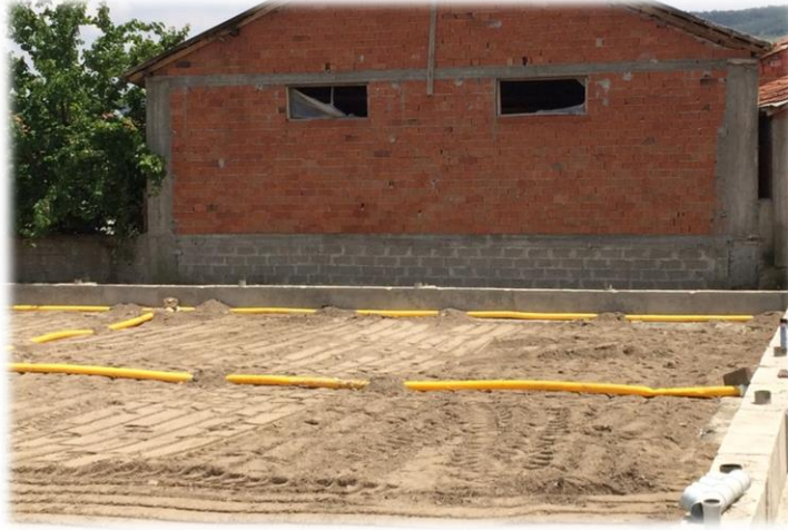
Balatlı (kırsal) Mahallesi 24m x 36m ölçülerinde ki sentetik çim yüzeyli futbol sahamızın drenaj boru çalışmasından fotoğraf.
