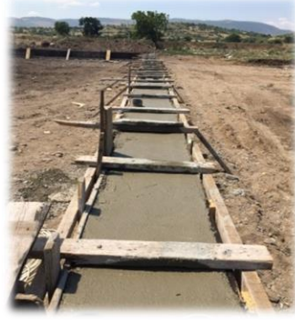
Balatlı Mahallesi Halı Sahası (24m x 36m) Çeribaşı Halı sahası hatıl beton kalıp çalışması (25m x 45m)
