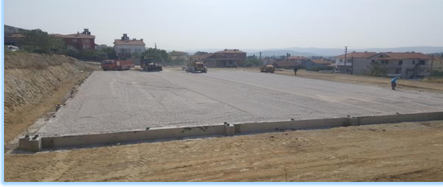
Emek Mahallesi Halı Saha Zemini Dolgu Çalışması
