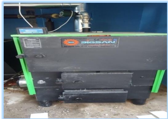
Binada tadilat çalışması ve 180.000 kcal/h kapasiteli katı yakıtlı kalorifer kazanı fotoğraflar
