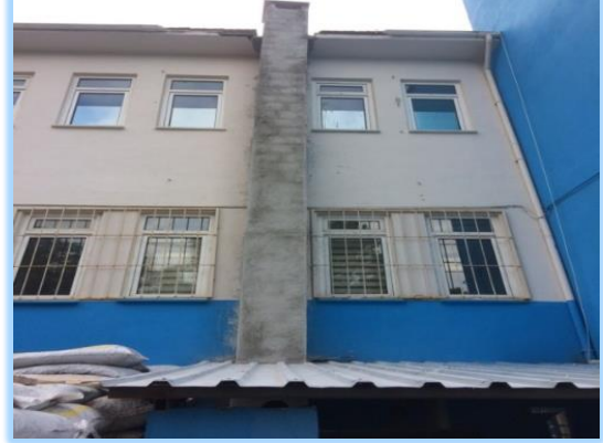
Binada oda tadilatı ve kalorifer kazanı için duman bacası inşaatı çalışmalarından fotoğraflar
