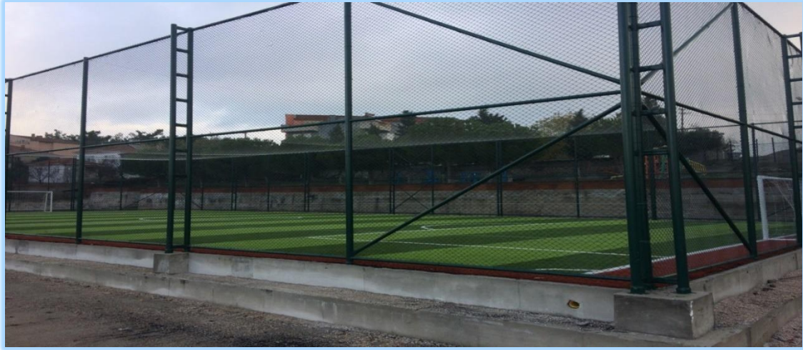
İskele Mahallesi 20 metre x 40 metre Sentetik Çim Yüzeyli Futbol Sahası
